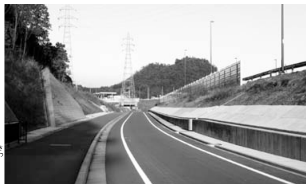
▲栗東水口道路側道3号線
