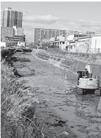
▲中ノ井川浚渫工事
