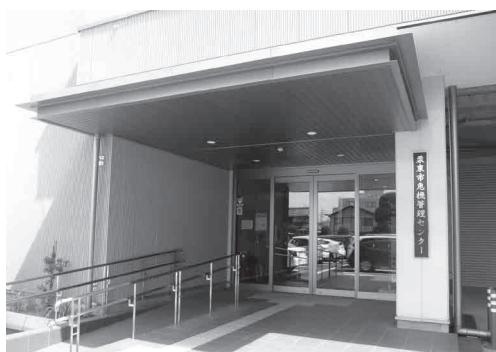
▲危機管理センター
