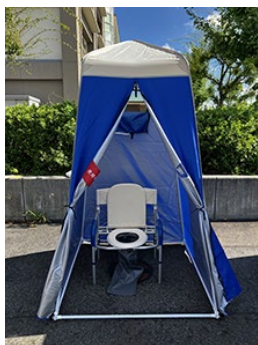
▲マンホールトイレ
