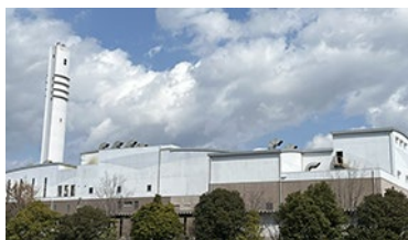
▲更新時期が迫る環境センター
