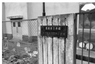
▲栗東市上水道 第2高区加圧ポンプ場
