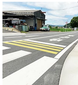
▲事故を受けた安全対策として①注意看板の設置(左)と ②路面カラー舗装がされました
