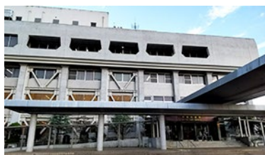
▲築50年を経過した市役所
