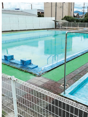
▲市内小学校プール
