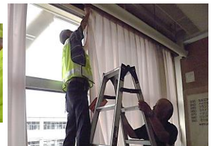
図書室カーテンレール修理支援
