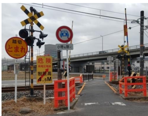
JR 草津線 治田踏切(上鉤地先)
